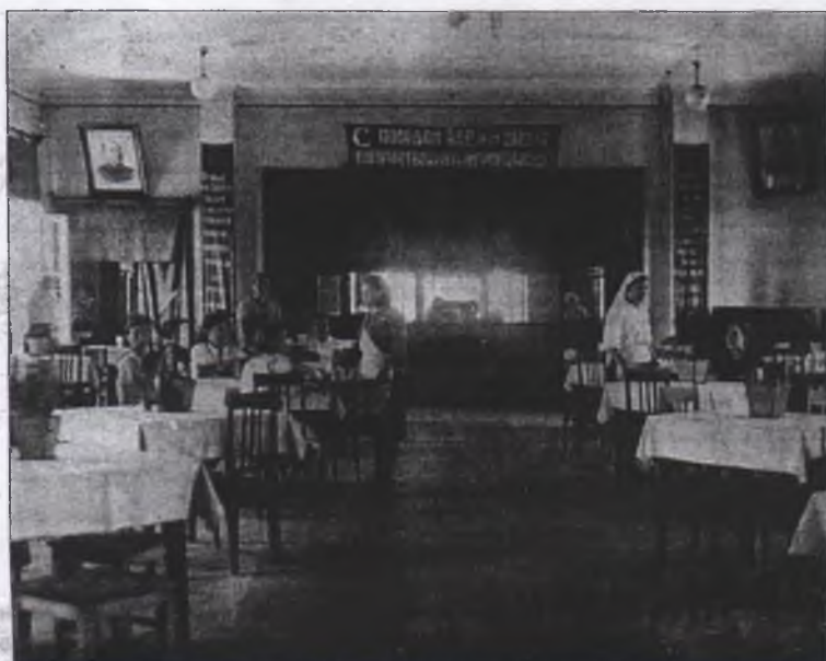
В столовой завода 169 (сейчас завод цветных металлов), 1945 год.
