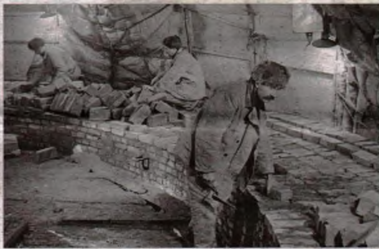
Декабрь 1941 г. Большой металлургический завод. Кладка трубы в тепляке на высоте 140 м
